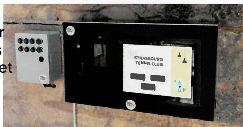
Borne de contrôle d'éclairage, de recharge et de paiement
